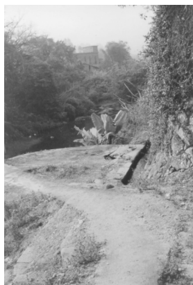
集成楼前石壁下水渠。
